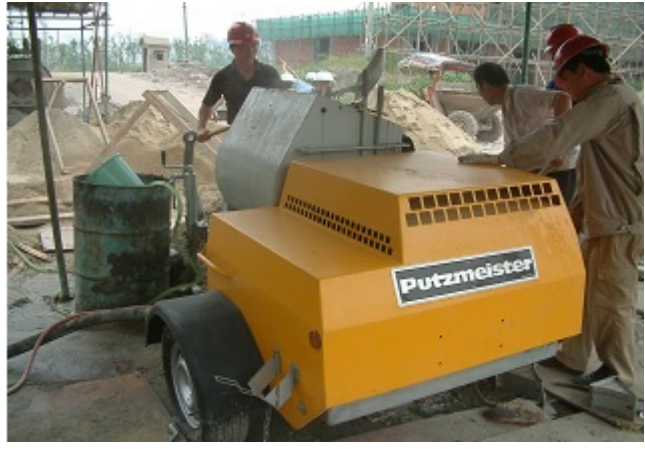
图 15: 大象砂浆设备在施工
