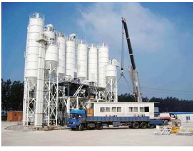
图 12: 三一重工干混砂浆生产线
